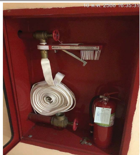
รูปที่ 2.4.6-4 ตู้เก็บสายน้ำดับเพลิงพร้อมอุปกรณ์
