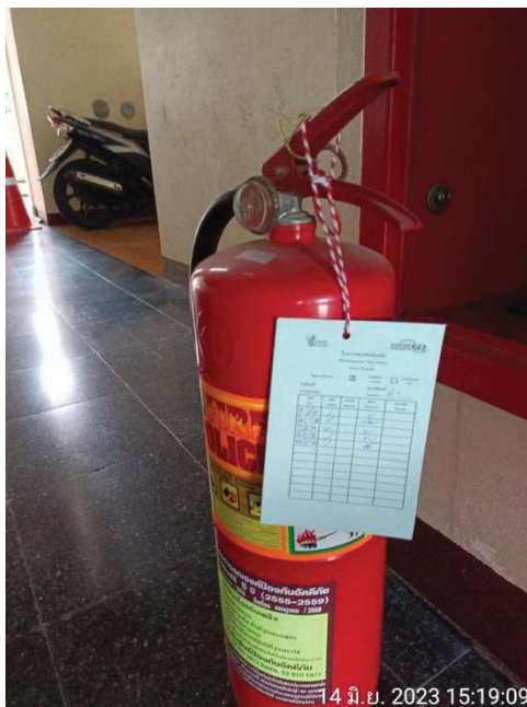
รูปที่ 2.4.6-6 ดับเพลิงมือถือ ชนิด ABC ขนาด 10 ปอนด์
