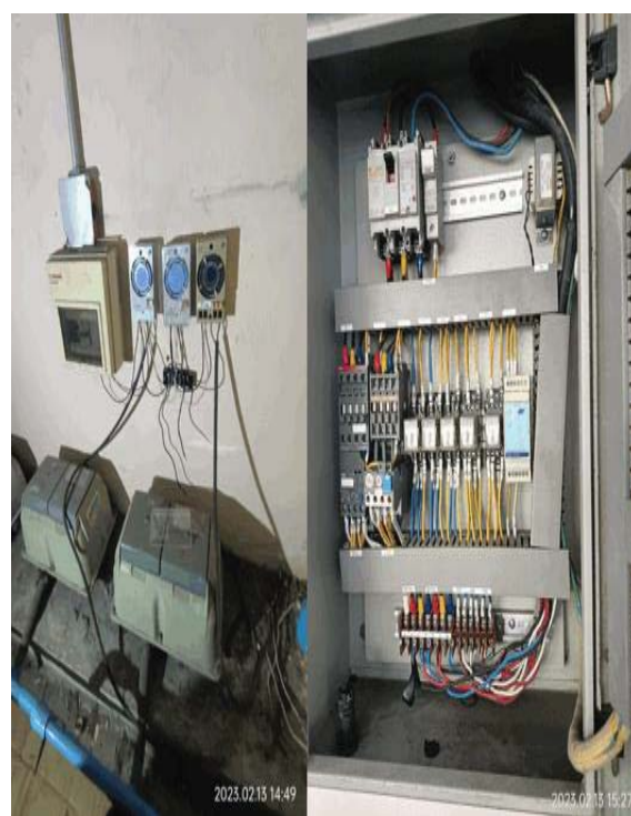
รูปที่ 2.4.2-2 ตู้ควบคุมระบบบำบัดน้ำเสีย
