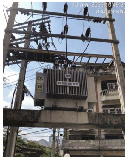
รูปที่ 2.4.5-2 หม้อแปลงไฟฟ้า ชุดที่ B
