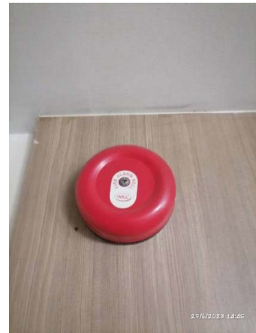
รูปที่ 2.4.6-11 กริ่งสัญญาณเตือนภัย
